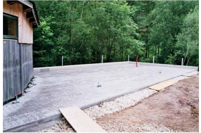
Die Wellverbundsteine wurden verlegt
