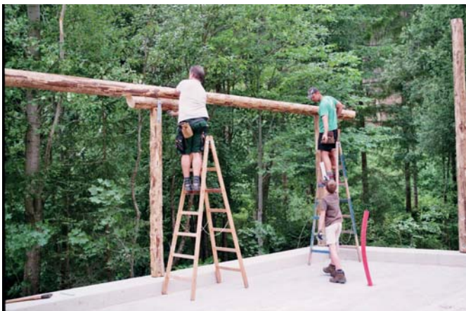
Die Pfetten werden verankert
